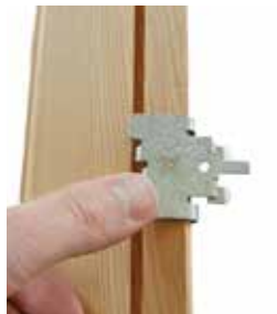
Montageclip positionieren und mit leichtem Druck einfügen
