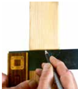
Markieren Sie die horizontale Position für den Anfangsclip
