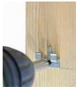
Fixieren sie den Anfangsclip an der markierten Position
