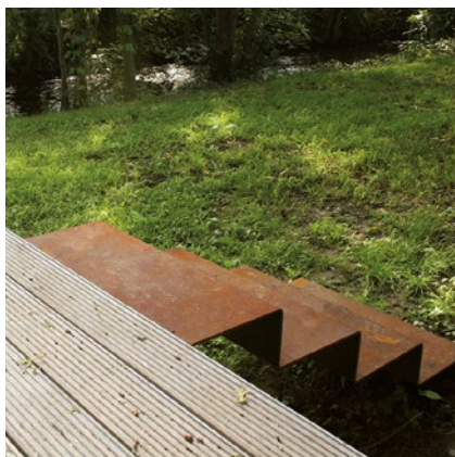
Treppen mit mehr als 6 Stufen werden mit einem hinteren U-Profil stabilisiert.
